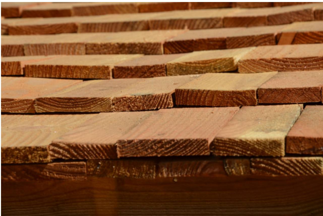
Træspån ligger med overlap, og mellemrum imellem hver enkelt spån på et par millimeter. Foto: Starupwood.dk
